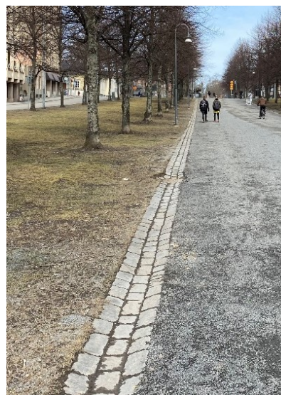
Kuva Hämeenpuiston keskikäytävän kivetystä hulevesikouru (FCG, 2023)
